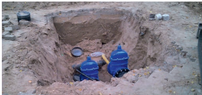
FIGUUR 2: REPARATIEWERKZAAMHEDEN AAN GASLEIDINGEN (FOTO L. MARING)
